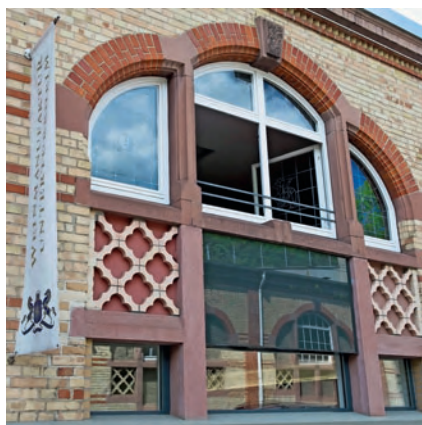
Die historische Fassadenornamentik war Impulsgeber für die Gestaltung der Innenräume
